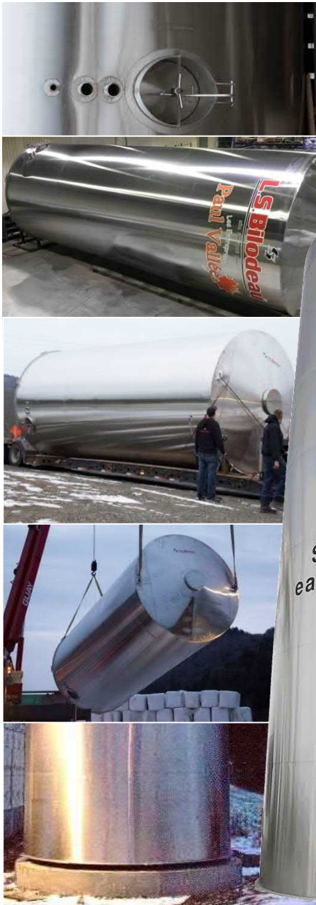
Livraison et installation d'un silo pour eau d'érable 21 000
